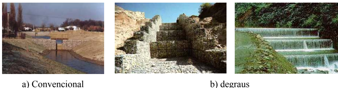
Figura 9 – Exemplo de um descarregadores em gabiões. Fonte: a) FranceGabion e b) Maccaferri.
